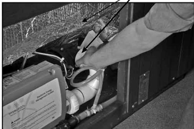
... a pumpa csatlakozásánál
