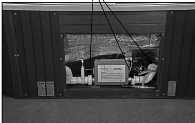
Gumigyűrűs / tömítéses illesztések
